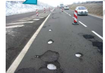
Chapelets de nids de poule sur un BBTM relativement récent
