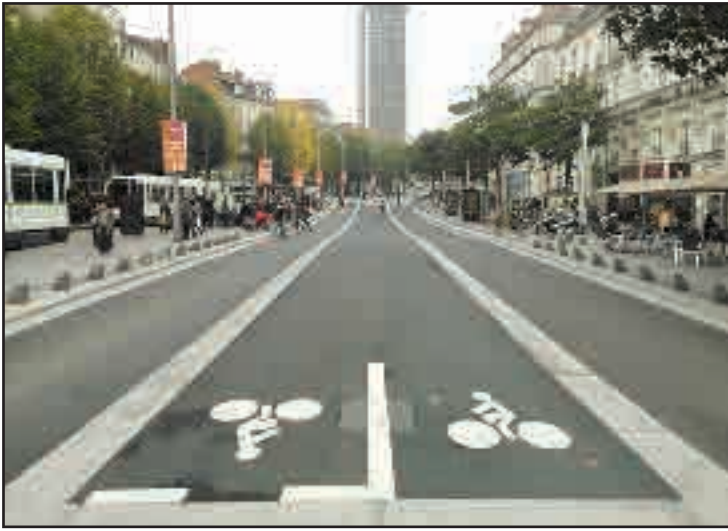
Photographie 7 : vue de la chaussée terminée : piste cyclable centrale, une voie de circulation canalisée pour transport en commun, trottoirs et lignes de tramway à double sens (crédit photo : Nantes Métropole)
