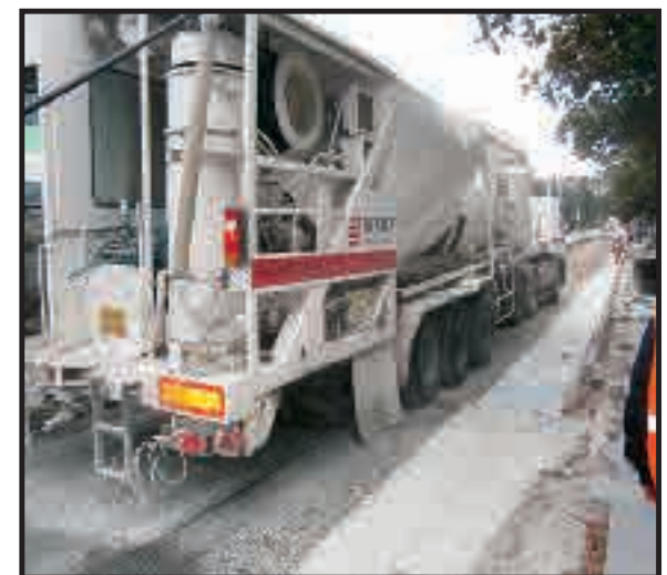
Photographie 2 : machine de stockage et de dosage en LHR, avec son alimentation en eau pour la machine de traitement malaxage (crédit photo : Nantes Métropole)
