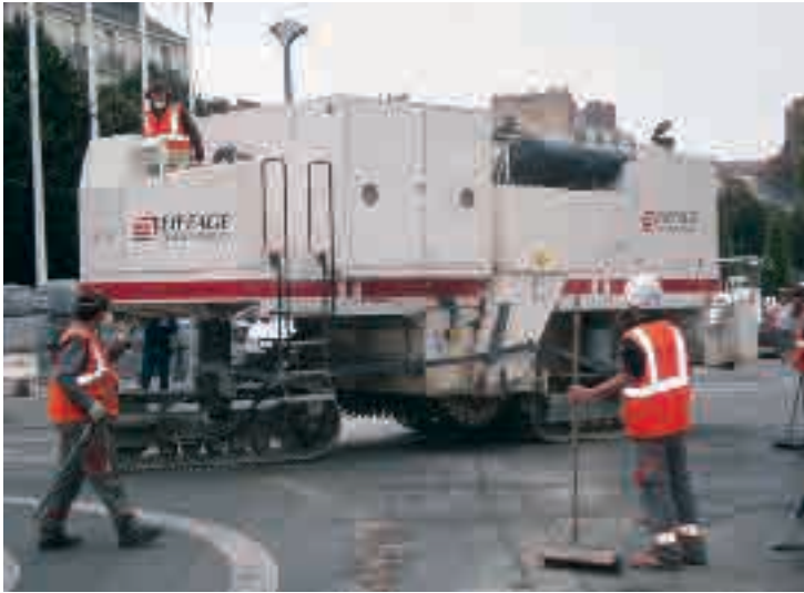
Photographie 3 : machine de traitement en place : Arc 700 (crédit photo : Nantes Métropole)
