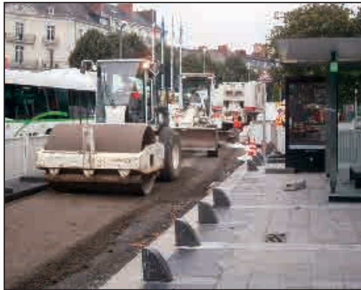
Photographie 4 : une station d'autobus, réalisation du retraitement en place, aperçu de l'atelier : machine de traitement-malaxage-précompactage, niveleuse mise à la côte, compacteur vibrant (type V3). (crédit photo : Nantes Métropole)
