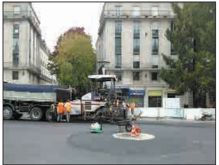
Photographie 5 : application de l'EME sur un des giratoires (crédit Photographie 6 : application de la couche de roulement en BBME 0/10 (crédit photo : Nantes Métropole)
