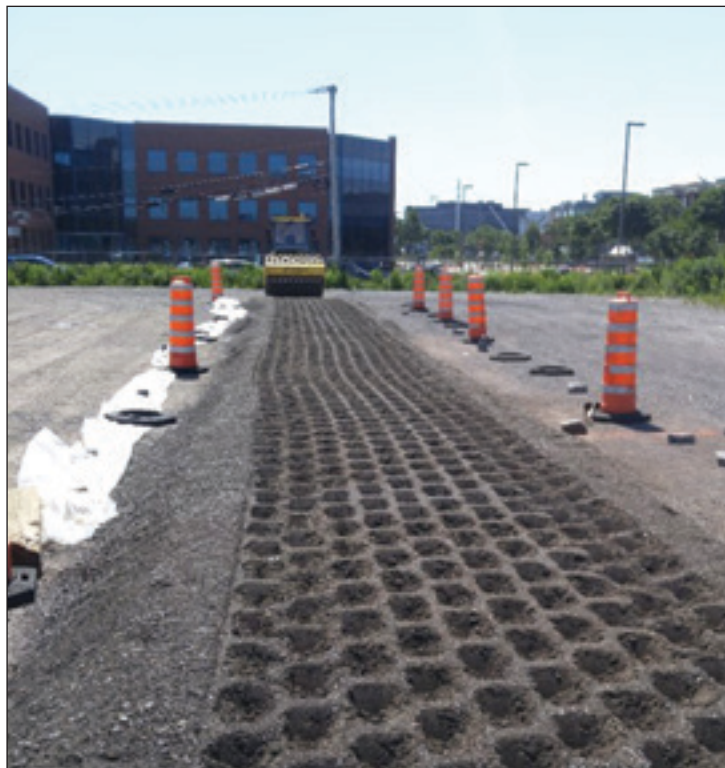
Figure 3 : Surface à la suite des premières passes avec le rouleau à pieds-de-mouton
